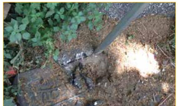
Utile per tagliare strati di asfalto e cemento, pulire e scrostare lo sporco, che spesso ricoprono la superficie e la giuntura del coperchio e permettere l'apertura.
