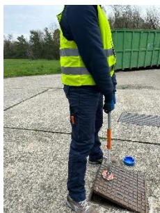
Figura 5 - Chiusino aperto e posizione dell'operatore eretta con gambe distese.
