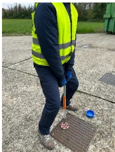
Figura 4 - Posizione di partenza per sollevamento chiusino con gambe piegate e schiena dritta
