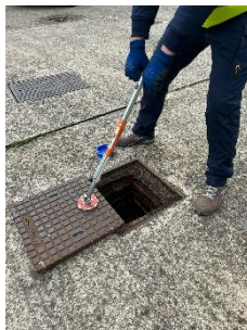
Figura 8 - Posizionamento operatore e piastra magnetica per chiusura chiusino.
