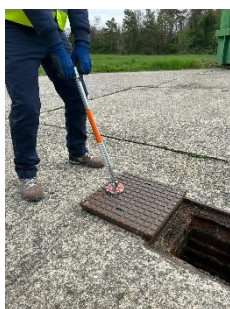
Figura 7 - Apertura completa chiusino tramite trascinamento.
